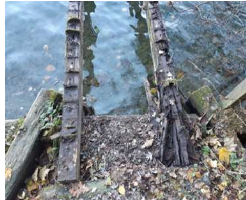
Abbruch der Fischerstege
